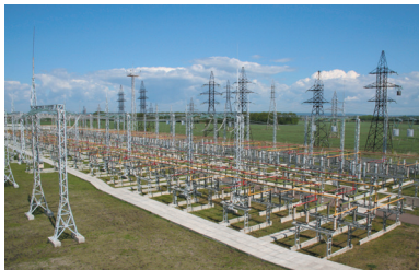
КТП-СЭЩ-Б(М) 220/110/35 кВ
