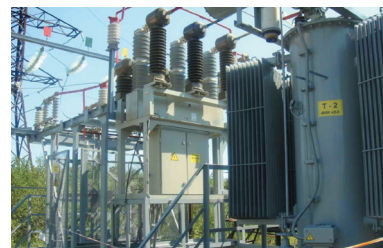
Реконструкция подстанций ST-7 35/6 кВ
